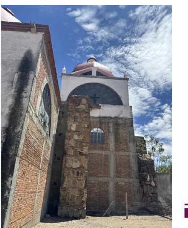
FOTO 2 Muros del presbiterio y capilla sur de espesor promedio de 0.30 m de tabique de barro rojo recocido, asentado y juntado con mortero de cal-arena. Paramento exterior aparente.
