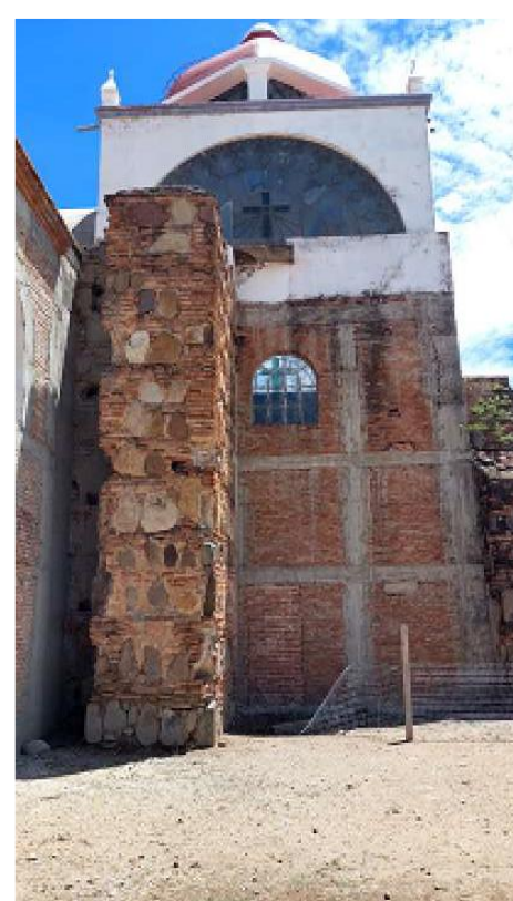
FOTO 5 Contrafuerte mixto adosado al muro contemporáneo del presbiterio.
