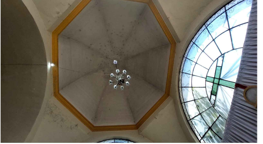
FOTO 4 Presencia de desprendimiento de aplanado en bóveda semiesférica de la capilla lateral norte.
