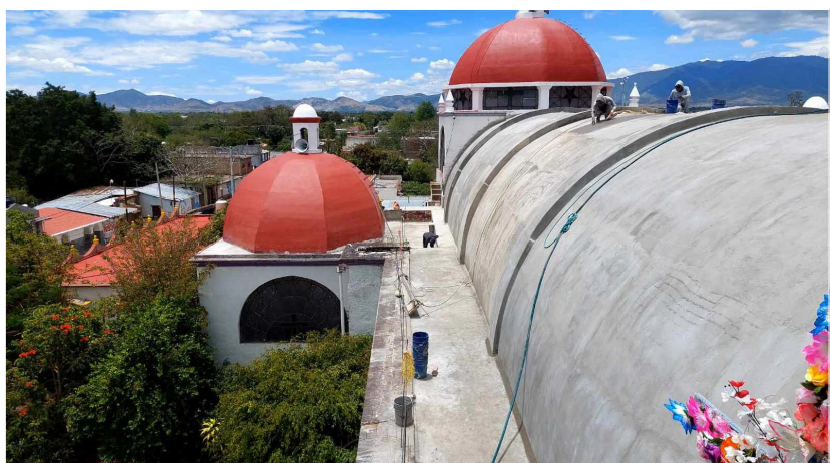
FOTO 1 Bóveda de cañon corrido de 15 cm de espesor promedio a base de concreto armado. Aplanado de mortero cemento-arena en intradós y en extradós de acabado con entortado de cal y arena.
