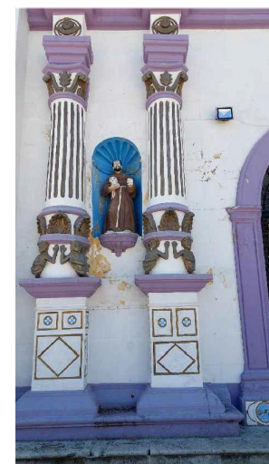
FOTO 2 Plastera de 0.70 m de diámetro con base de 0.70 x 0.35 m, dimensión promedio. Fábrica de tabique de barro rojo recocido, asentado y junteado con mortero cal-arena. Aplanado fino de mortero cal-arena y acabado de pintura vinílica.
