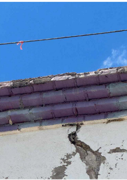
FOTO 5 Grieta en muro de fábrica mixta y desportillamiento en cornisa a causa de sismos.
