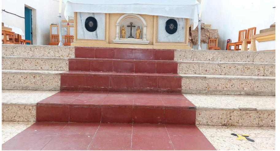
FOTO 9 Grieta y desportillamiento de loseta de terrazo en el piso a causa del uso cotidiano y la falta de mantenimiento.
