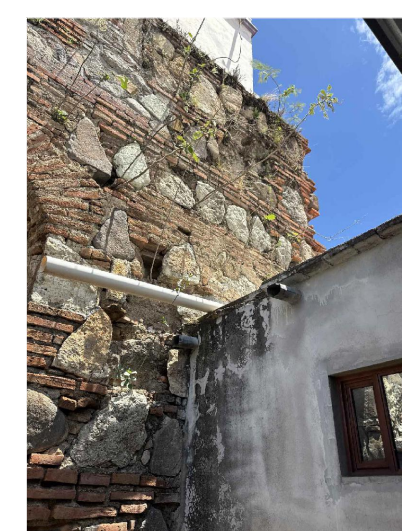
FOTO 3 Presencia de manchas de líquenes y pérdida de aplanado en muro a causa del intemperismo.
