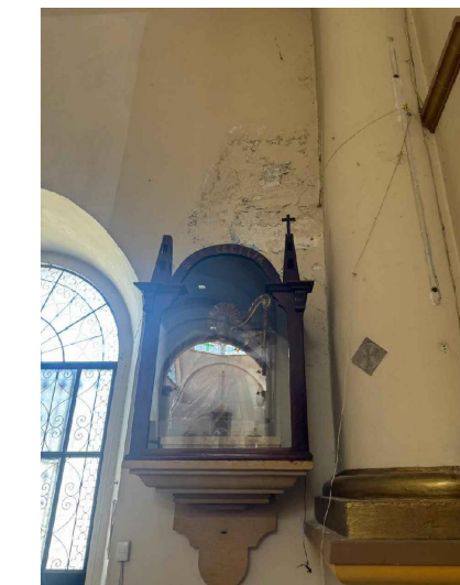
FOTO 4 Pérdida del aplanado en muro de fábrica mixta a causa de falta de mantenimiento y humedad.
