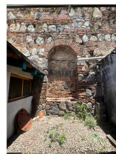
FOTO 5 Presencia de flora nociva en muro testero, a causa de la humedad y falta de mantenimiento.
