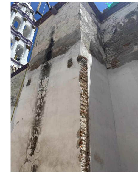
FOTO 8 Pérdida de aplanado en contrafuerte, disgregación en material base a causa de sismos.
