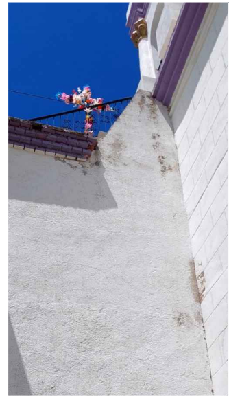
FOTO 6 Presencia de manchas en muros a causa de la humedad y falta de mantenimiento.
