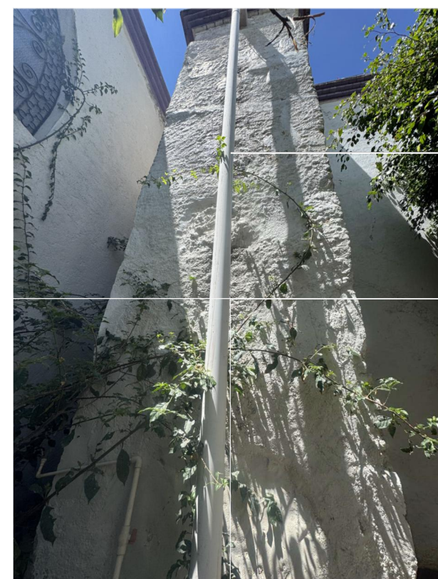
FOTO 2 Contrafuerte adosado al muro norte.
