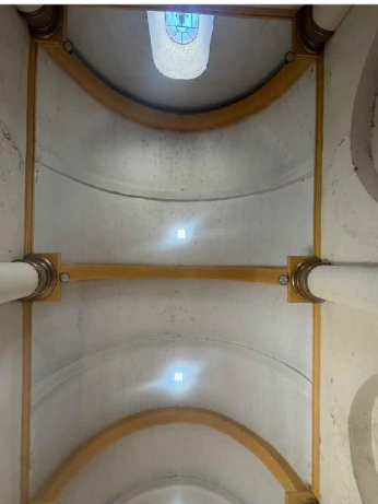
FOTO 8 Bóveda de cañon corrido de 15 cm de espesor promedio a base de concreto armado. Acabado de aplanado de mortero cemento-arena y acabado con pintura vinílica.
