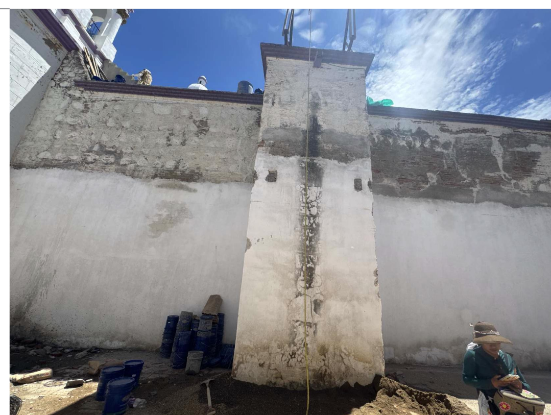
FOTO 7 Contrafuerte adosado al muro mixto sur de la nave.
