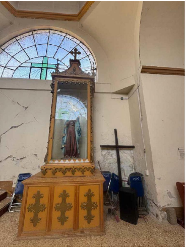
FOTO 2 Pérdida parcial del aplanado en muro de tabique de barro rojo recocido a causa del sismo, así como el desportillamiento base de la columna.
