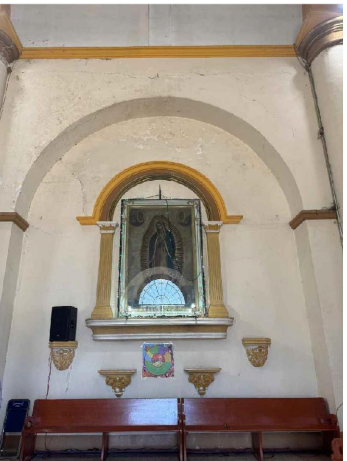
FOTO 7 Muro mixto de piedra de la región y tabique de barro rojo recocido, de espesor promedio de 2.05 m, asentado y juntado con mortero de cal-arena. En ambos paramentos con aplanado de cal-arena y acabado de pintura vinílica.
