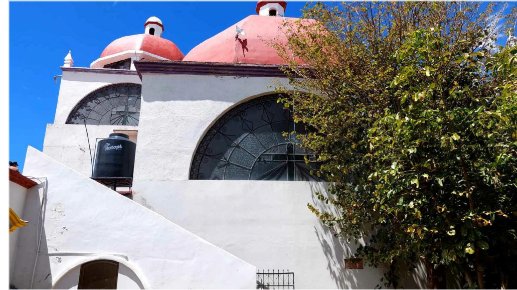
FOTO 2 Pérdida parcial de aplanados en muros a causa de la falta de mantenimiento.
