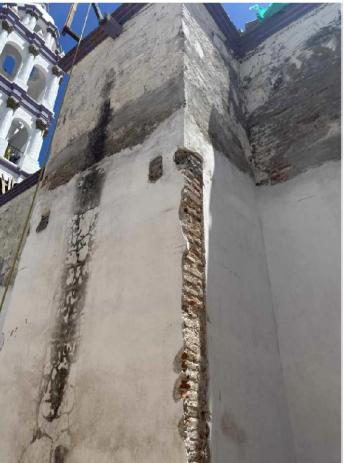
FOTO 4 Contrafuerte de fábrica mixta de 1.48 x 2.70 m, de sección promedio, de piedra de la región y tabique de barro rojo recocido, asentado y juntado con mortero de cal-arena, terminado de pintura vinílica.
