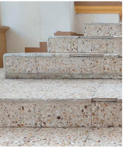
FOTO 8 Desportillamiento de loseta de terrazo en el piso a la fatiga del material.
