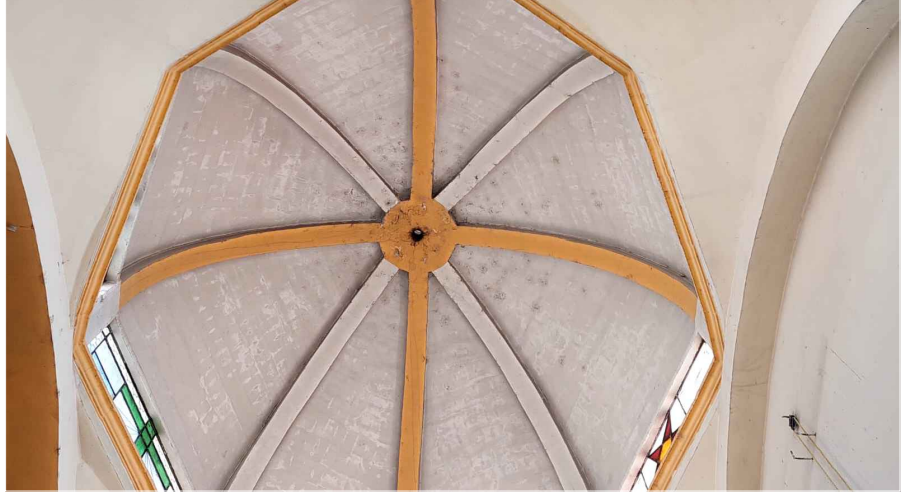
FOTO 10 Presencia de desprendimiento de aplanado en la cúpula del templo.
