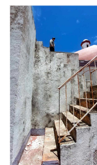
FOTO 2 Presencia de manchas de líquenes y desprendimiento de aplanado en muro y escalera que da acceso a la cubierta.
