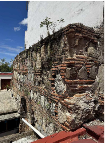
FOTO 3 Muro testero con espesor promedio de 1.20 m de fábrica mixta de piedra de la región y tabique de barro rojo recocido, asentado y juntado con mortero de cal-arena. Acabado aparente.
