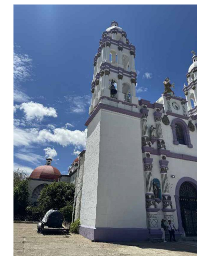
FOTO 1 Torre de campanario norte de dimensión promedio de 4.00 x 4.00 m, fábrica de piedra de la región y tabique de barro rojo recocido, asentado y junteado con mortero cal-arena. Aplanado de mortero de cal-arena y acabado de pintura vinílica.
