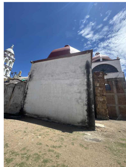
FOTO 9 Mancha de líquen a causa de la humedad por consecuencia de las bajadas de agua pluvial.
