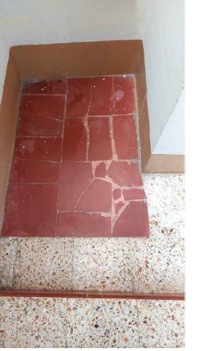
FOTO 6 Grietas y desportillamiento en loseta del piso a causa del sismo.
