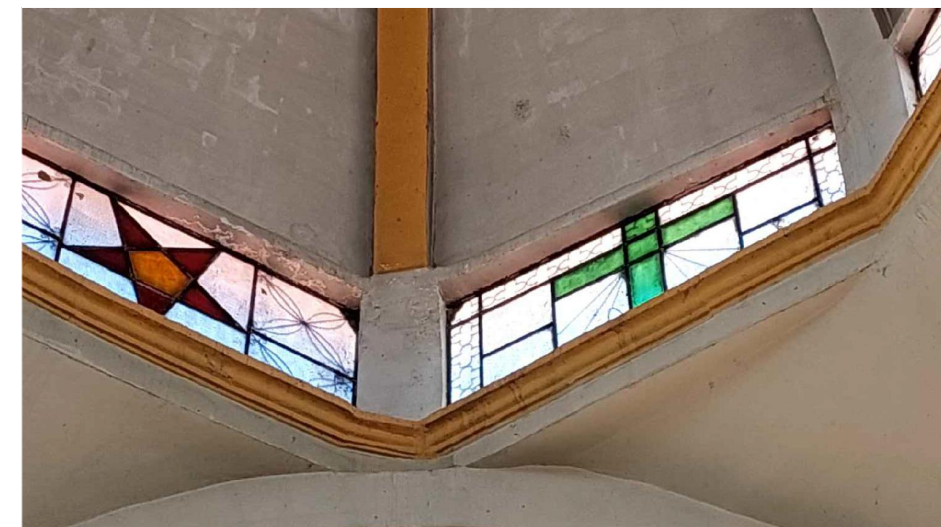
FOTO 5 Tambor de cúpula de muros de tabique de barro rojo recocido y columnas de concreto armado, de 0.35 m espesor promedio, en ambos paramentos con aplanado de mortero cemento-arena y acabado de pintura vinílica.
