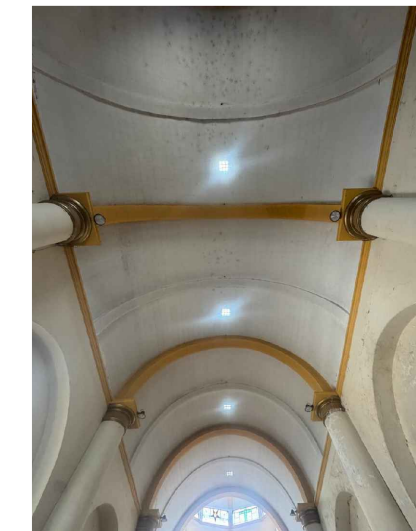
FOTO 7 Desprendimiento de aplanado en intradós de bóveda a causa de la filtración de agua.
