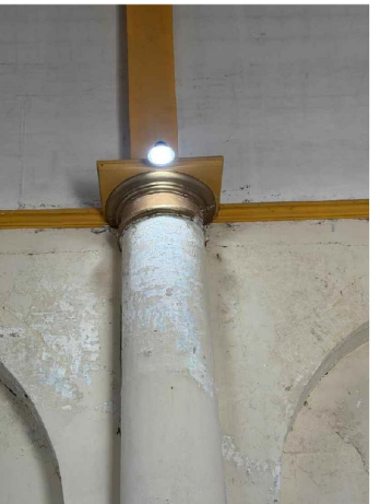
FOTO 6 Media caña de adobe de 1.00 m de diámetro con base de 1.20 x 0.70 m, de sección promedio, asentado y juntado con mortero de arcilla. Acabado de cal-arena y acabado de pintura vinílica.
