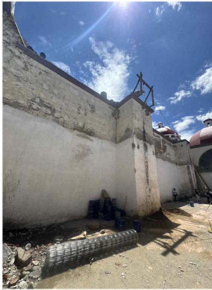
FOTO 7 Pérdida de aplanado en muros y contrafuertes, a causa de sismos.
